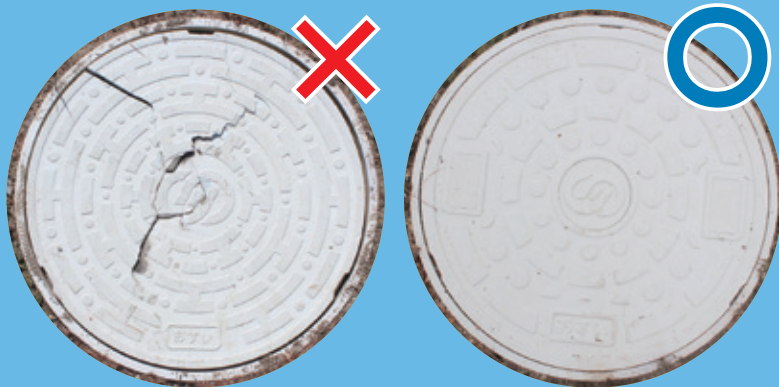
破損している 公共汚水ます
