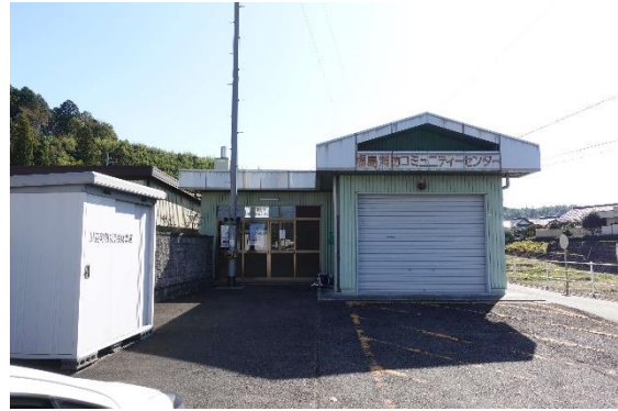
8. 福島消防詰所
