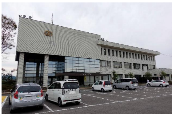
5. 川辺町庁舎及び保健センター
