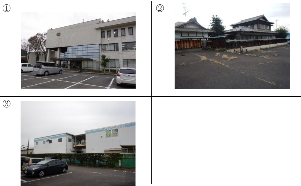
図表 周辺の状況（令和元年9月撮影）
