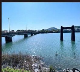
▲ 大正期に近代吊橋として建設された旧山川橋の主塔が遺されており、その上部を左岸側に見ることができる。
