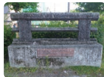
↑ 東光寺公園に竣工当時の高欄が保存されています
