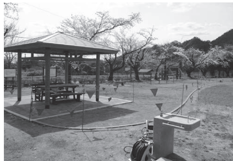
工事中的下麻生ふれあいパーク
