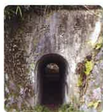
▲登山道入口のトンネル
