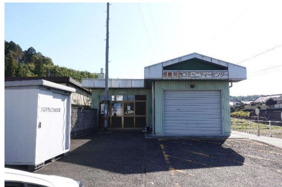
8. 福島消防詰所
