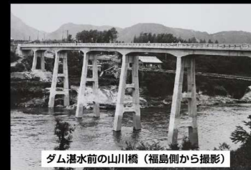
ダム湛水前の山川橋（福島側から撮影）
