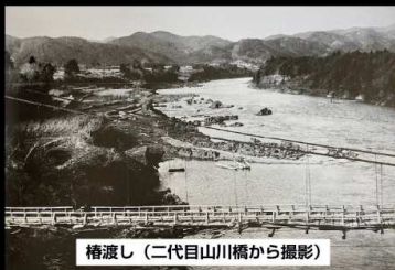
橋渡し（二代目山川橋から撮影）
