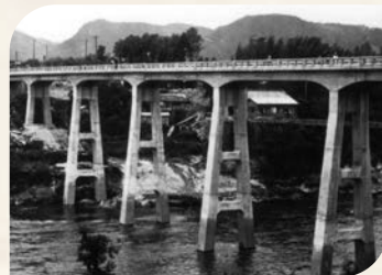
山川橋(昭和12年竣工時)
