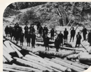
検査委員による管材検査
